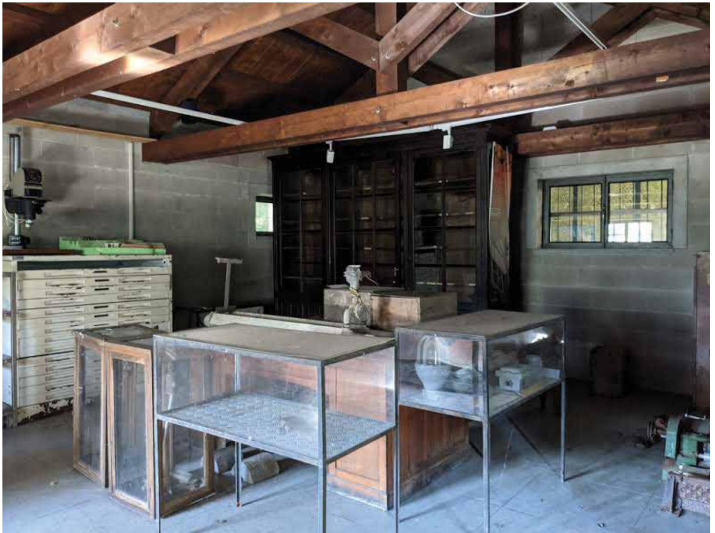
Locale ex biblioteca - primo piano
