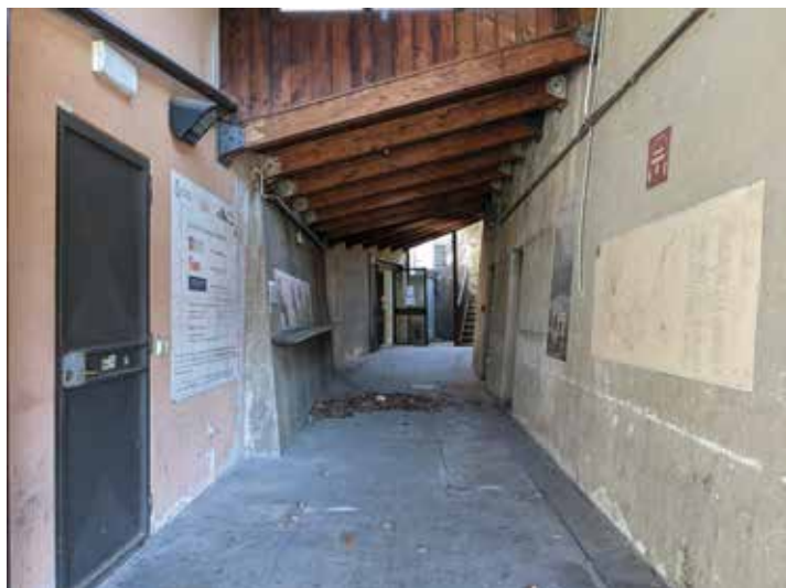
Patio coperto di accesso ai locali e al percorso di visita
