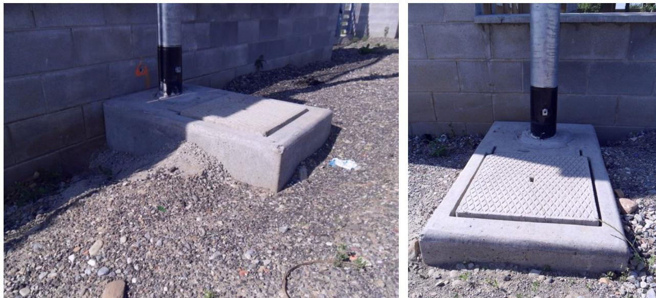
Figura 8 – Plinto prefabbricato per palo IP con pozzetto integrato
